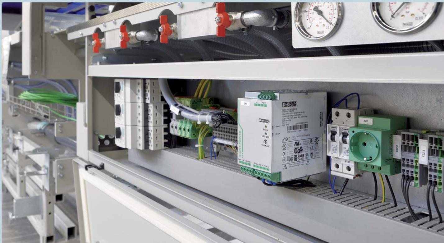
*Источник питания с технологией SFB обеспечивает быстрое и надежное срабатывание автоматических выключателей в случае появления ошибки*
