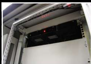
Система мониторинга CMC III для контроля состояния сейфа
