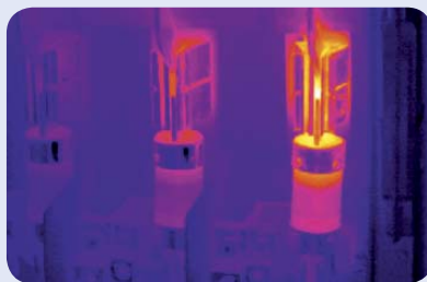
Повреждения предохранителей
