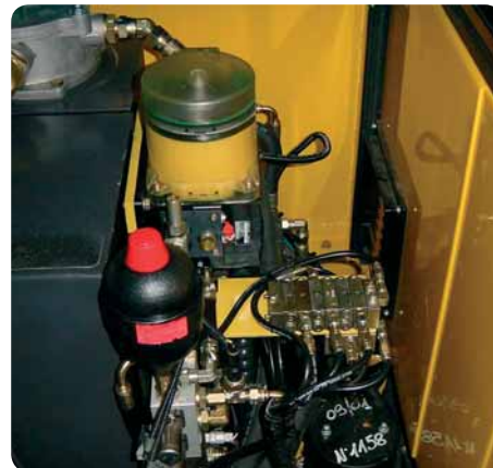
Насосный узел со встроенной управляющей электроникой на машине KOMATSU PW95.
