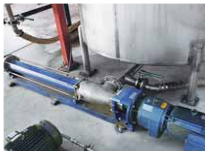
Насос seerex BN 5-24 , продукт: гуща, давление: 4-6 бар, производительность: 2 м 3 /ч
