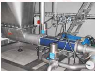
Насос seepex BTCS 10-12, продукт: томатная паста из емкостей, температура: 20°C давление: 3 бар, вязкость: не текучая, производительность: 0,5-1,3 м 3 /ч
