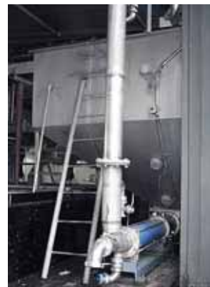
Насос seerex BTM 70-12 для размельчения и одновременной транспортировки яблок, давление: 6-12 бар, температура: 20-30°C, производительность: 15-20 м 3 /ч
