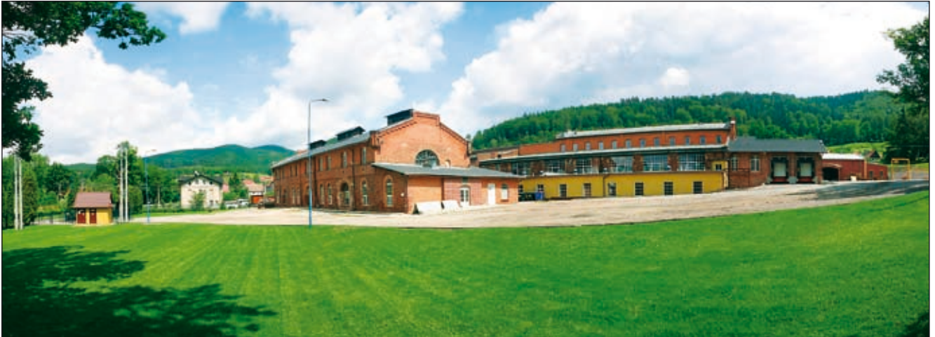
Производственный цех завода ZPAS в Пшигуже (Przygórze)
