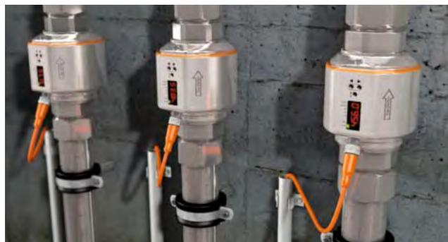
**Магнитно-индуктивные датчики потока со встроенным мониторингом температуры (уплотнительный материал EPDM), сертификат KTW / W270**
