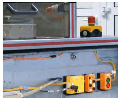
Контроллеры безопасности AS-i, могут применяться везде, где нужно реализовать децентрализованную технологию безопасности.
