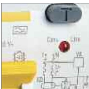
Светодиодная индикация наличия напряжения на клеммах «Нагрузка» и встроенная защита от длительных (265 В; 0,5 с) перенапряжений сети (АД12М).
