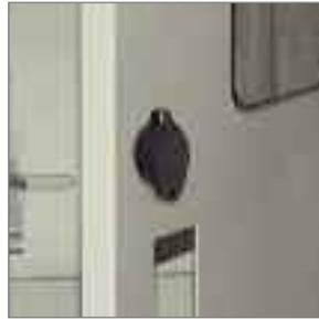
Предусмотрена возможность пломбировки оперативной панели в закрытом состоянии (с помощью отверстий в пылевлагонепроницаемой фурнитуре).
