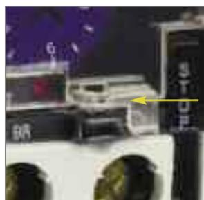
Пломбирование прозрачной крышки, защищающей диск регулировки уставки, исключает несанкционированный доступ к регулировкам рабочих значений тока уставки.
