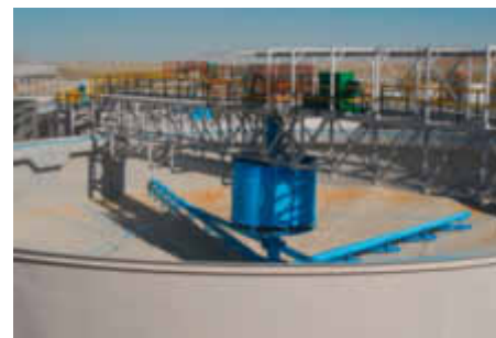
CCD сгуститель диаметром 35 м на производстве урана
