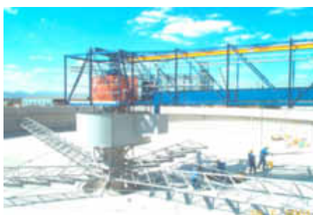
Мост радиального сгустителя диаметром 40 м
