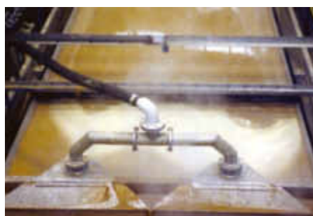
Промывочный распределитель "рыбий хвост"
