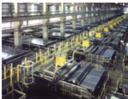
Крупнейшее в мире отделение фильтрации с ленточными фильтрами - Нчанга, Замбия
