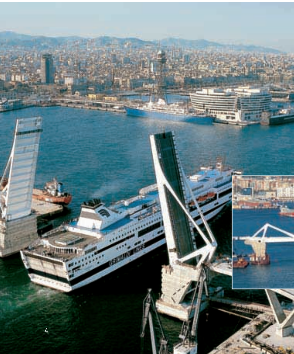
Барселона. На сегодняшний день самый большой мост с двумя разводными пролетами в мире работает на больших шарнирных подшипниках с диаметром 671 мм, не требующих технического обслуживания.
