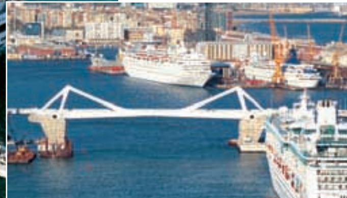
Барселона. На сегодняшний день самый большой мост с двумя разводными пролетами в мире работает на больших шарнирных подшипниках с диаметром 671 мм, не требующих технического обслуживания.
