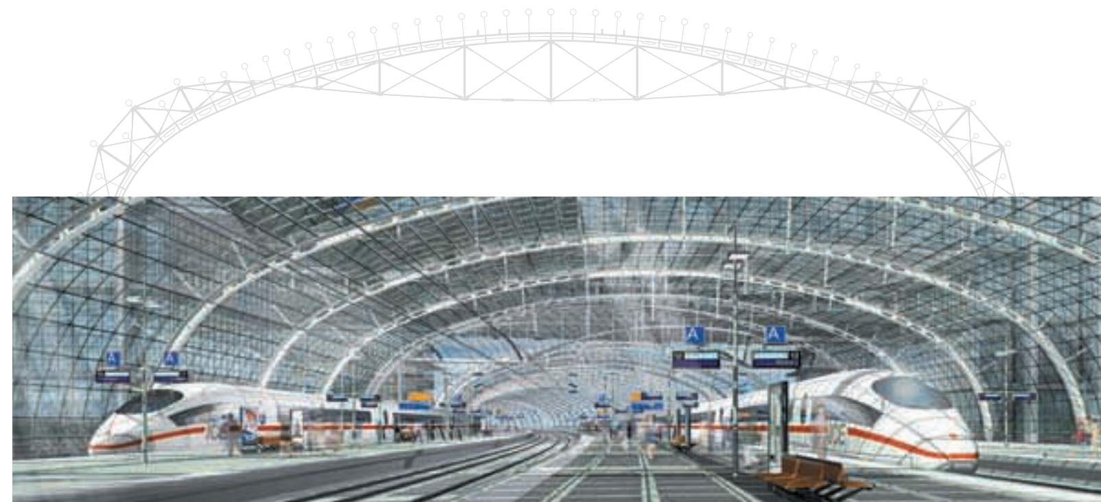
Берлинский вокзал «Лертер»: кровельная конструкция крупнейшего европейского вокзала перекрывает около 300 метров перрона и содержит многочисленные шарнирные подшипники/подвески ELGES (компьютерная симуляция фирмы © «Archimation», Берлин)
