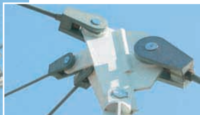
Изячно и в то же время под воздействием огромной нагрузки: крепление несущего троса кровельной конструкции
