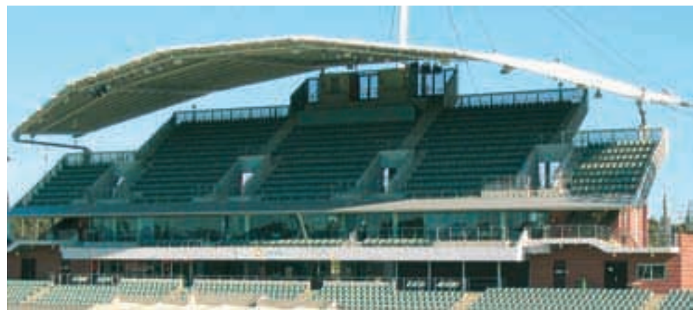
Государственный Центр хоккея в Сиднее: все точки примыкания тросов по периметру кровли и на опорах установлены на шарнирные подшипники с покрытием ELGOGLIDE®
