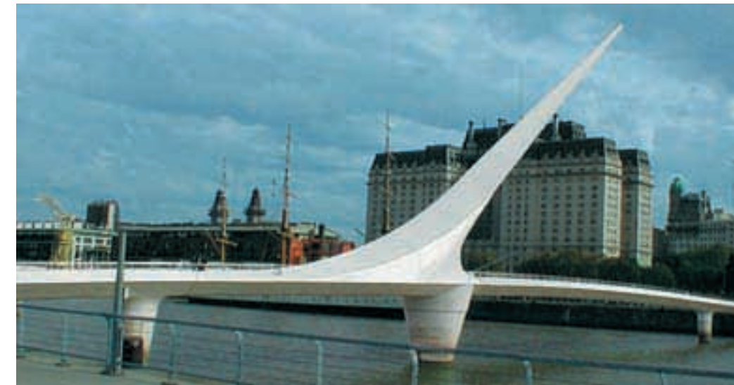
Буэнос-Айрес. Пешеходный мост «Пуэнте де ла мухер» в Старом порту - шедевр архитектуры и техники. Это же относится и к подшипниковым узлам разводного элемента моста, которые рассчитаны на эксплуатацию в течение 50 лет без необходимости технического обслуживания. Типичный случай применения подшипников крупного размера ELGES высочайшего качества фирмы «INA», дающего право на обладание сертификатом качества «X-life».
