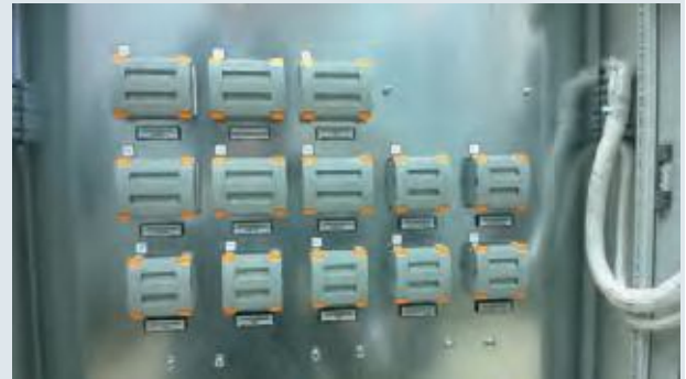
Рис. 2 Внешняя панель шкафа с блоками FAME 6/6+1
