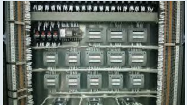
Рис. 1 Внутренняя сторона шкафа с блоками FAME 6/6+1 и гибридными измерительными клеммами PTU
