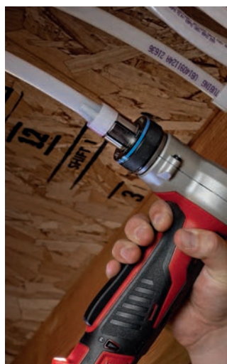
Монтаж труб Upronor PE-Xa
