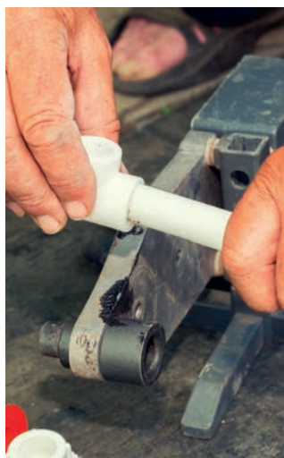
Монтаж полипропиленовых труб
