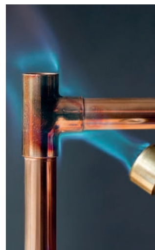
Монтаж медных труб
