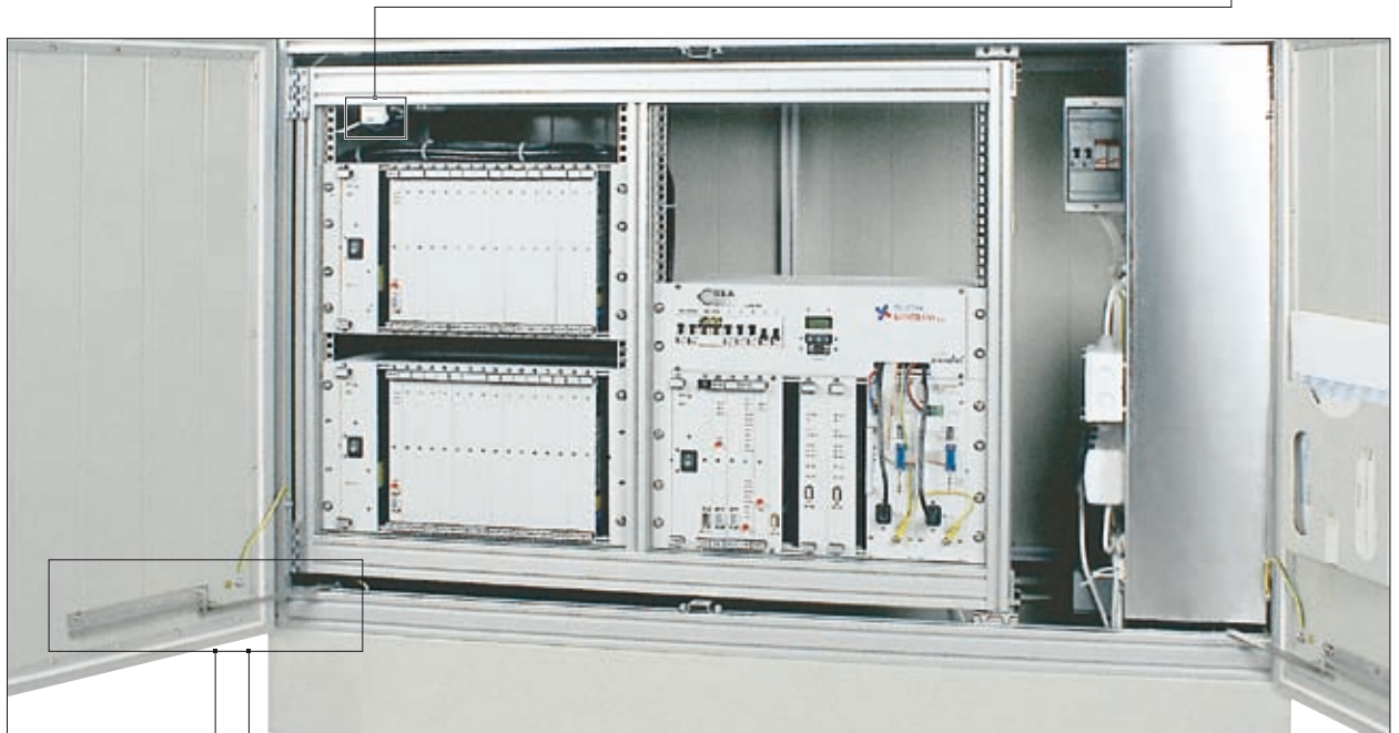
Пример монтажа выключателя и ограничителя открытия двери в шкафу
