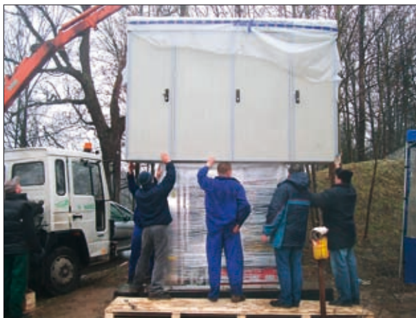
Шкаф в период реконструкции
