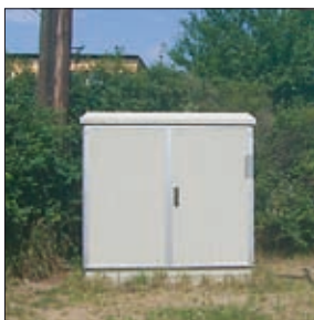
Шкаф перед реконструкцией
